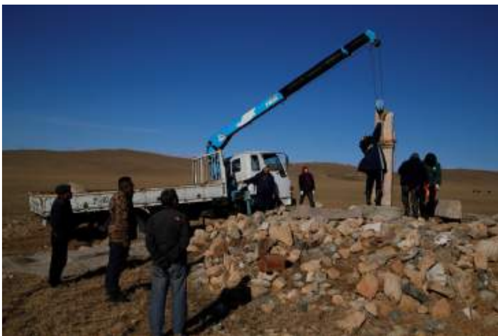
Зураг 1. Могойн шинэ усны гэрэлт хөшөөг зөөж шилжүүлэх үйл явц (2021.10.16-18)
